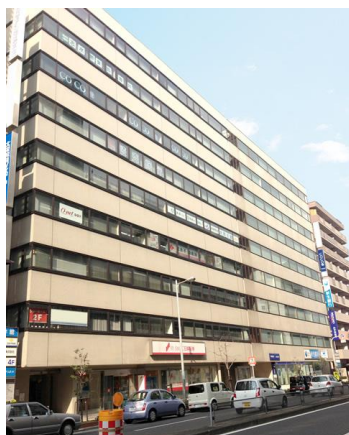
三共堺東ビル外観
